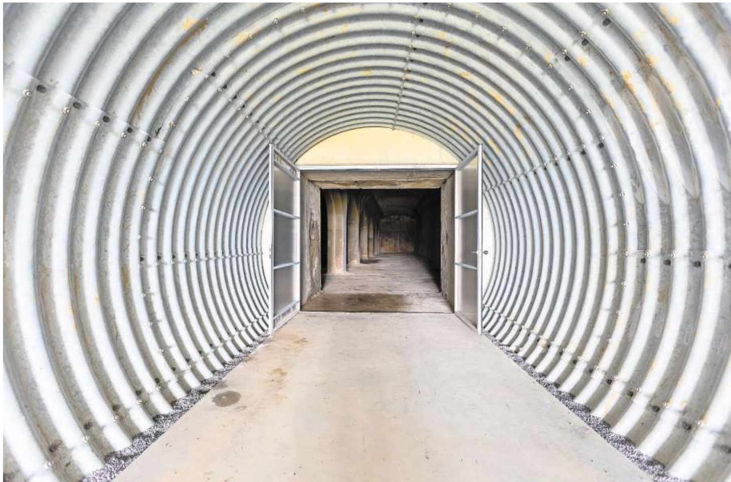
Der Eingang zum Wasserreservoir Oberallmig in Baar, Austragungsort des zweiten Sommerklänge-Konzerts.
