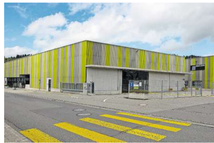
Das Gebäude steht in Unterägeri.
